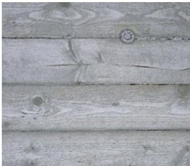
Bild 1: Brettstruktur sägerau, ungehobelte Bretter
