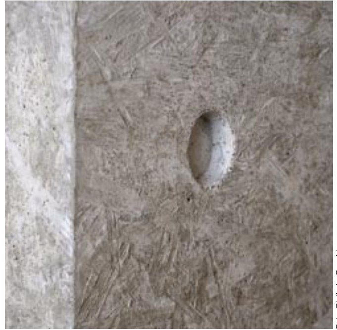
Bild 6: Mit OSB-Platten geschaltete Oberfläche mit Kante
