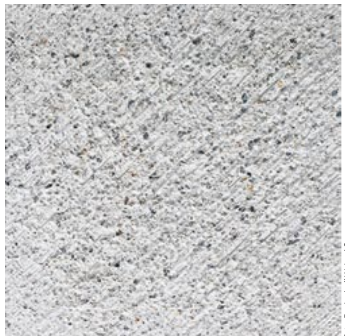
Bild 11: Scharrierte Betonoberfläche
