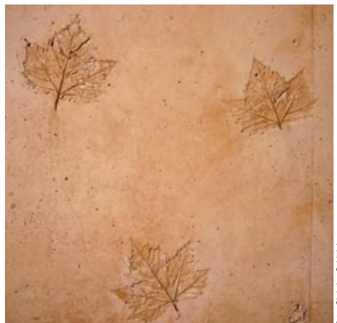
Bild 13: Durchgefärbter Sichtbeton mit in der Schalung eingelegten Blättern, Waldorfschule in Augsburg, 2007, Architekten: ott architekten, Augsburg
